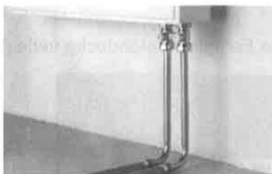
Beispiel REHAU-Heizkörperanschlußsystem Schiebehülse HAS/Sockelleiste HASSO
