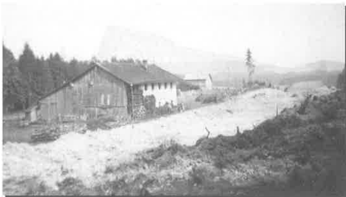
Bau der B85 beim Anwesen Konrad Fuihl in den 50iger Jahren.
